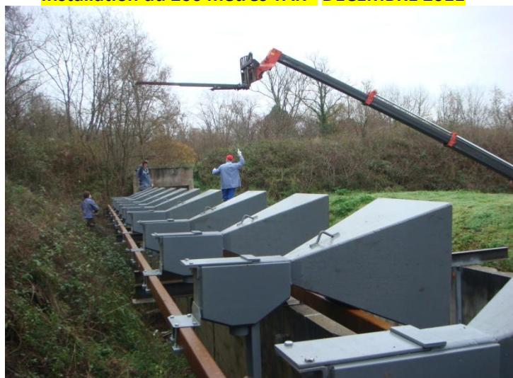
Pose sur châssis double de 25 m. déporté sur du vide
