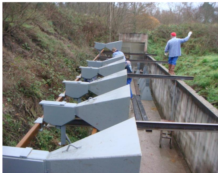
Haute voltage sur un muret pour guider le grutier
